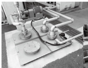
廃熱回収タンクと送水ポンプ
