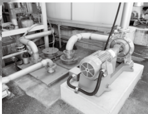
廃熱回収タンクと送水ポンプ
