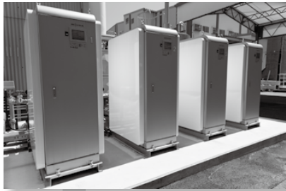
ボイラ給水加温ユニット
